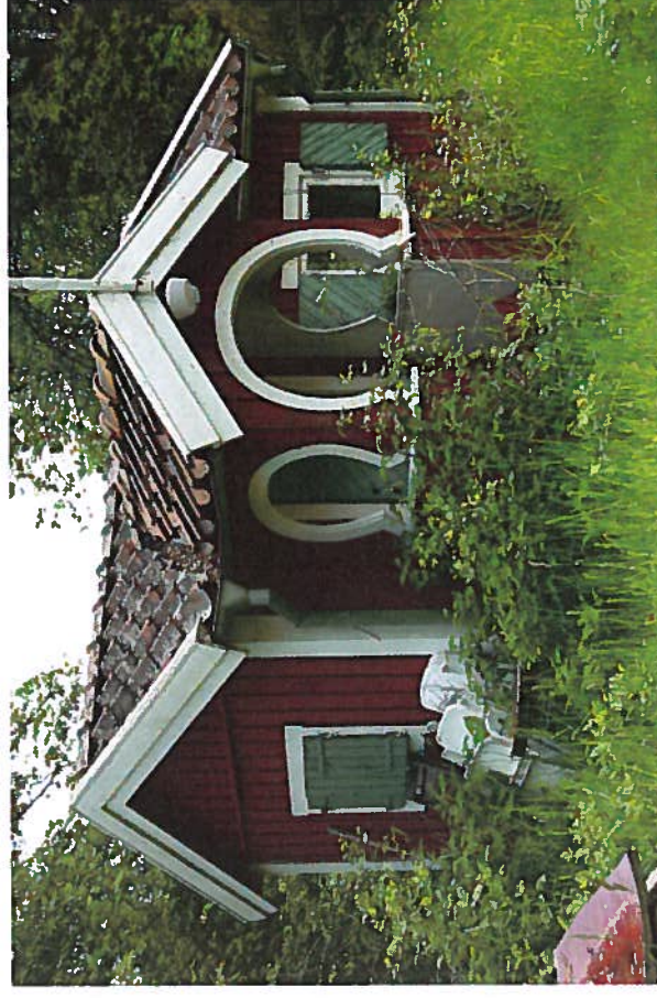
Fasad mot söder. På taket ligger det enkupiga lertegel som troligtvis även legat på Draguddens huvudbyggnad.
